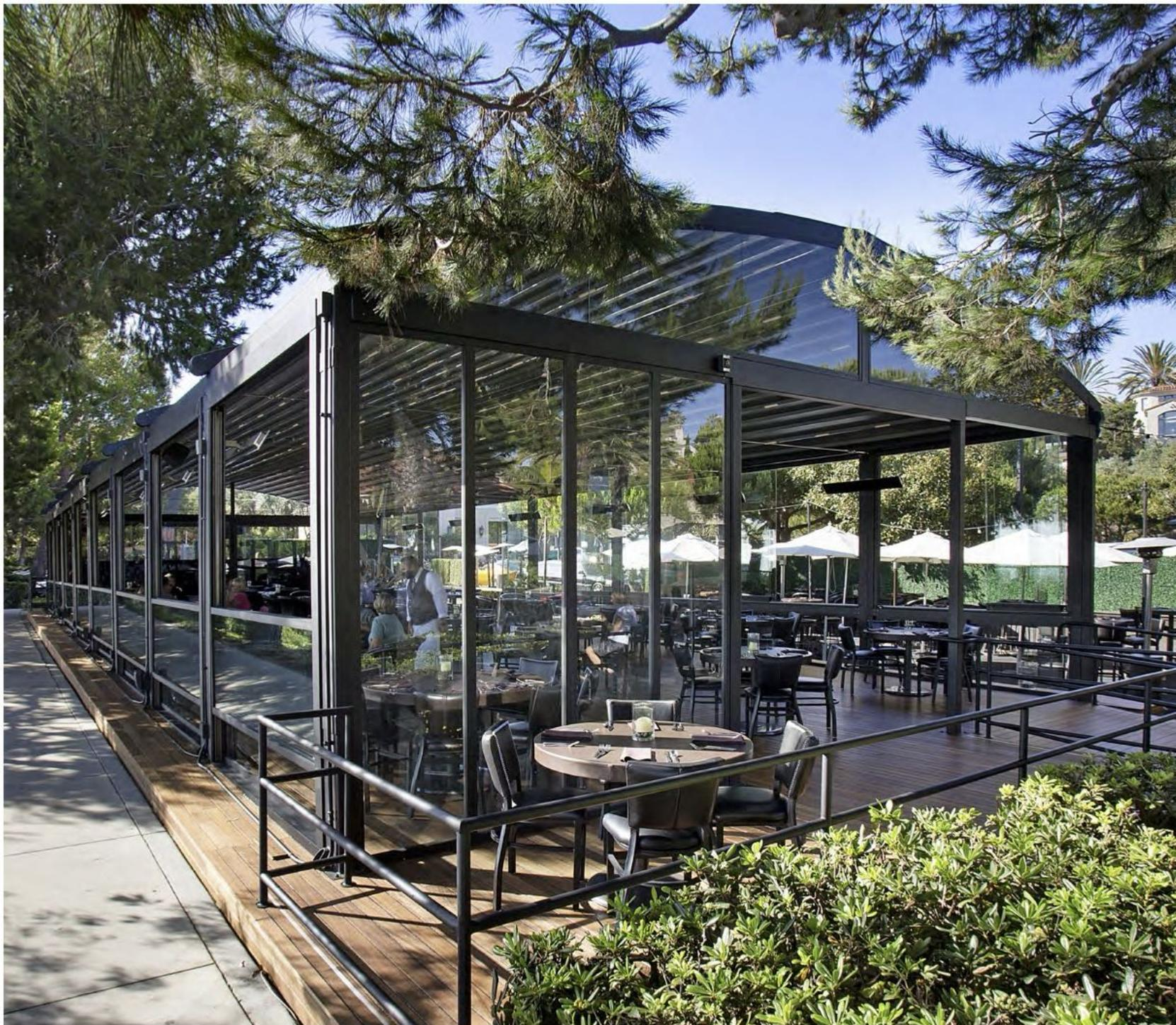
Nel vivace paesaggio della California, questo progetto di ristorante è stato splendidamente progettato con un sistema di pergola retrattile arrotondato Coral e parapetti in vetro regolabili automatici.
